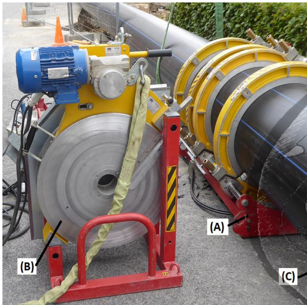
PREPARACIÓN PARA SOLDADURA A TOPE EN TUBOS PE DN560. MAQUINARIA: BLOQUE ALINEADOR (A), PLACA REFRENTADORA (B), PLACA CALEFACTORA (C) Y UNIDAD DE CONTROL Y ACCIONAMIENTO (D)
