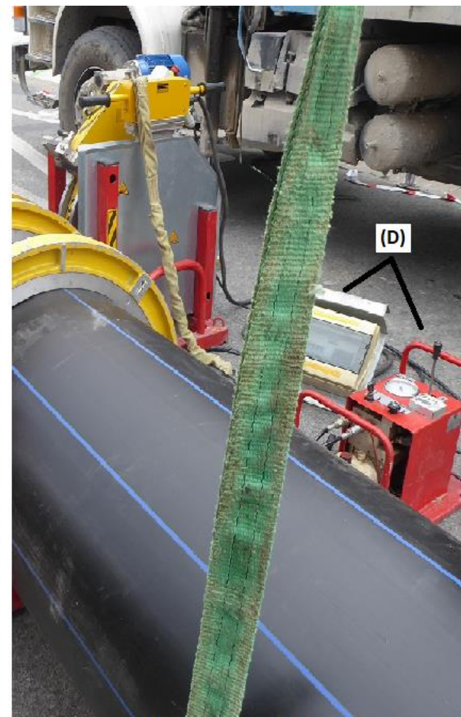
PREPARACIÓN PARA SOLDADURA A TOPE EN TUBOS PE DN560. MAQUINARIA: BLOQUE ALINEADOR (A), PLACA REFRENTADORA (B), PLACA CALEFACTORA (C) Y UNIDAD DE CONTROL Y ACCIONAMIENTO (D)
