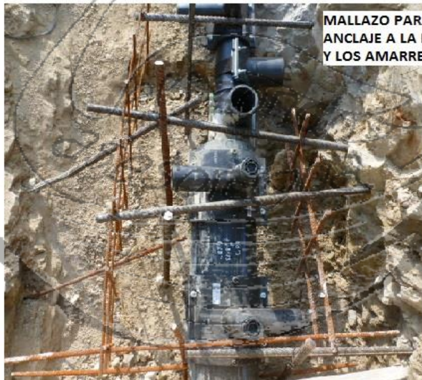
ANCLAJE FINAL CONTRA LA TUFA/MARGA
