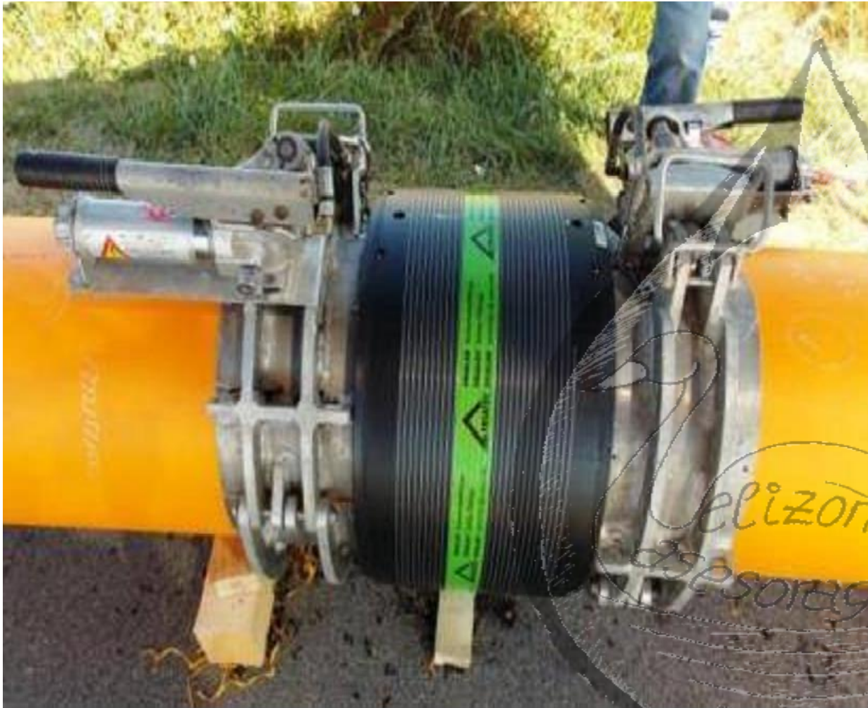
REDONDEADORES PARA EVITAR OVALIZACIONES QUE REPERCUTAN EN LA ELECTROSOLDADURA
