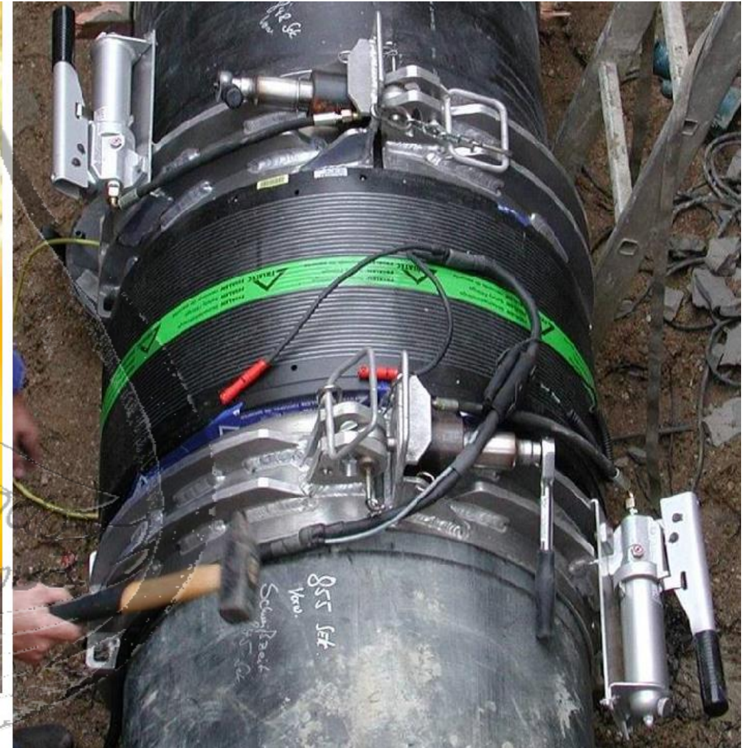
REDONDEADORES PARA EVITAR OVALIZACIONES QUE REPERCUTAN EN LA ELECTROSOLDADURA
