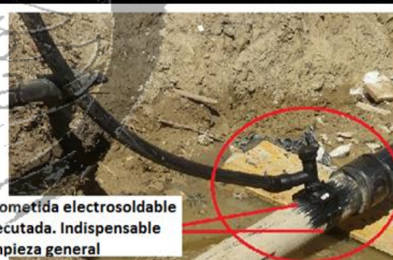
CODIFICACIÓN MANGUITO ELECTROSOLDABLE
