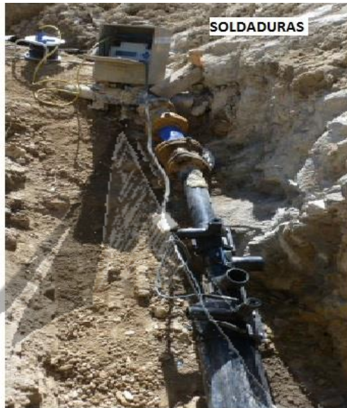
INSTALACIÓN DE ACOMETIDAS ELECTROSOLDABLES DE TIPO ABRAZADERA COMO PUNTOS DE AMARRE CON LAS TUBERÍAS INSTALADAS
