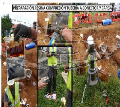
INSTALACIÓN CONECTOR PARA SEGUIR A BRIDA UNIÓN CON EL OTRO EXTREMO DE TUBERÍA
