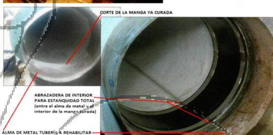
ENTUBACIÓN NUEVA TUBERÍA TIPO "PRIMUS LINE" DESDE BOBINAS EN FORMATO PLEGADO
