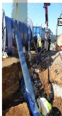
INSTALACIÓN DE TUBERÍA PRIMUS LINE PARA SUSTITUCIÓN TUBERÍAS ABTO. A PRESIÓN
