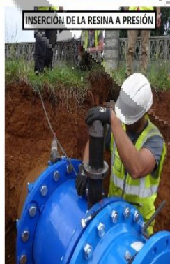
INSTALACIÓN DE TUBERÍA PRIMUS LINE PARA SUSTITUCIÓN TUBERÍAS ABTO. A PRESIÓN
