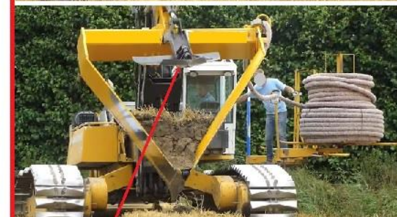
FINAL INSTALAC. IZADO VÉRTICE DE ATAQUE
