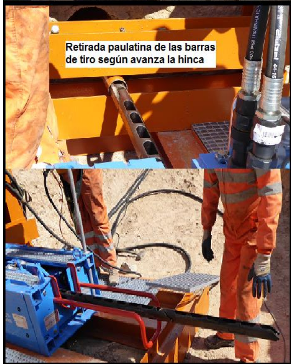
Final del proceso de tiro y desmontaje plataforma
