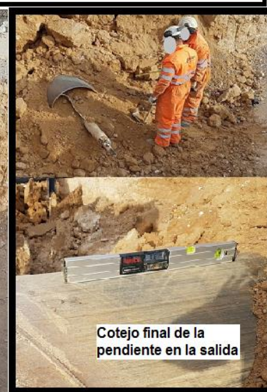
Sigue el golpeo neumático hasta que sale el cabezal de arrastre y la tubería de acero
