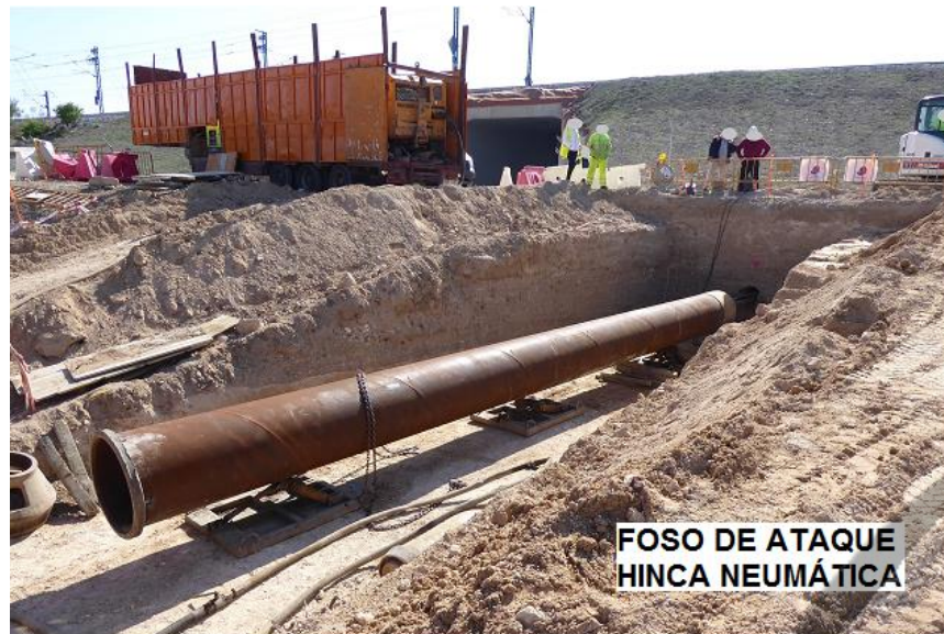
PLATAFORMA DE TIRO Y DE GUIADO HINCA
