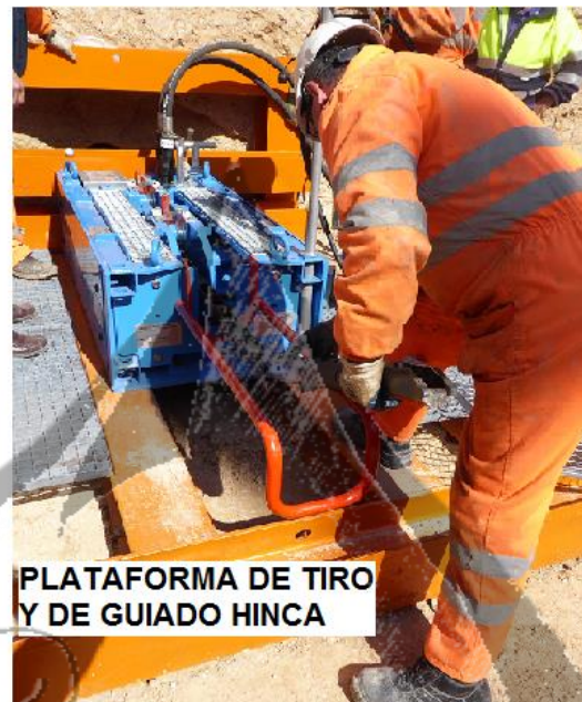
AVANCE DE LA TUBERÍA CON EL TIRO Y PENETRACIÓN EN EL TERRENO CON EL SOLO ESFUERZO DEL TIRO
