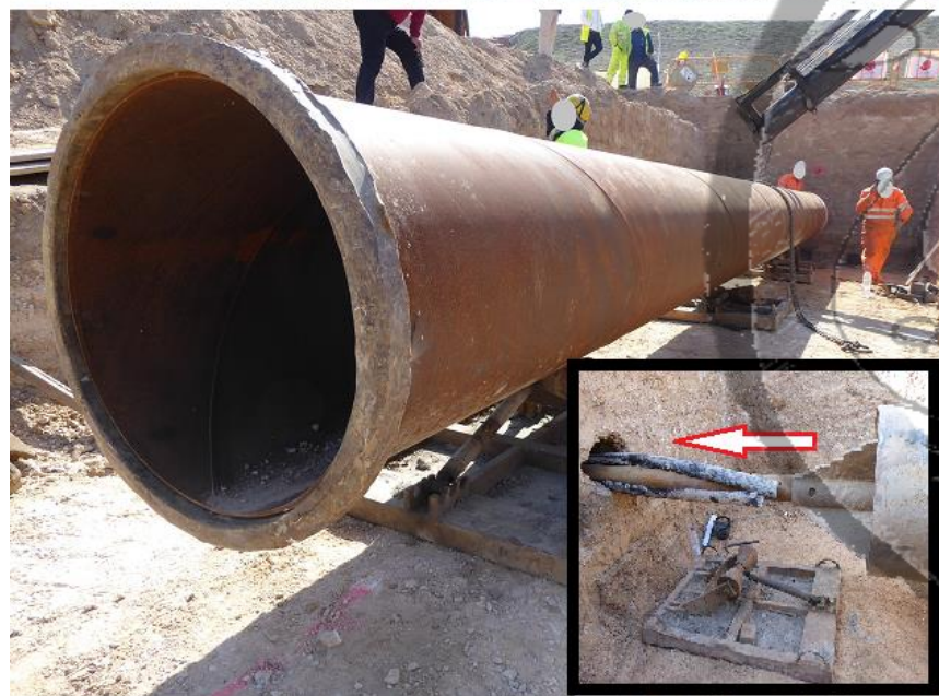
AVANCE DE LA TUBERÍA CON EL TIRO Y PENETRACIÓN EN EL TERRENO CON EL SOLO ESFUERZO DEL TIRO
