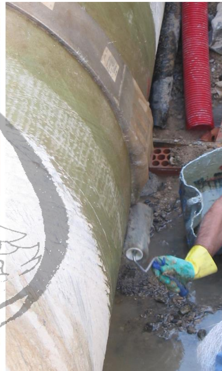
COLOCACIÓN DE LAS CAPAS DE FIELTRO DE FIBRA DE VIDRIO SUPERPUESTAS E IMPREGNADAS CON RESINA DE POLIÉSTER
