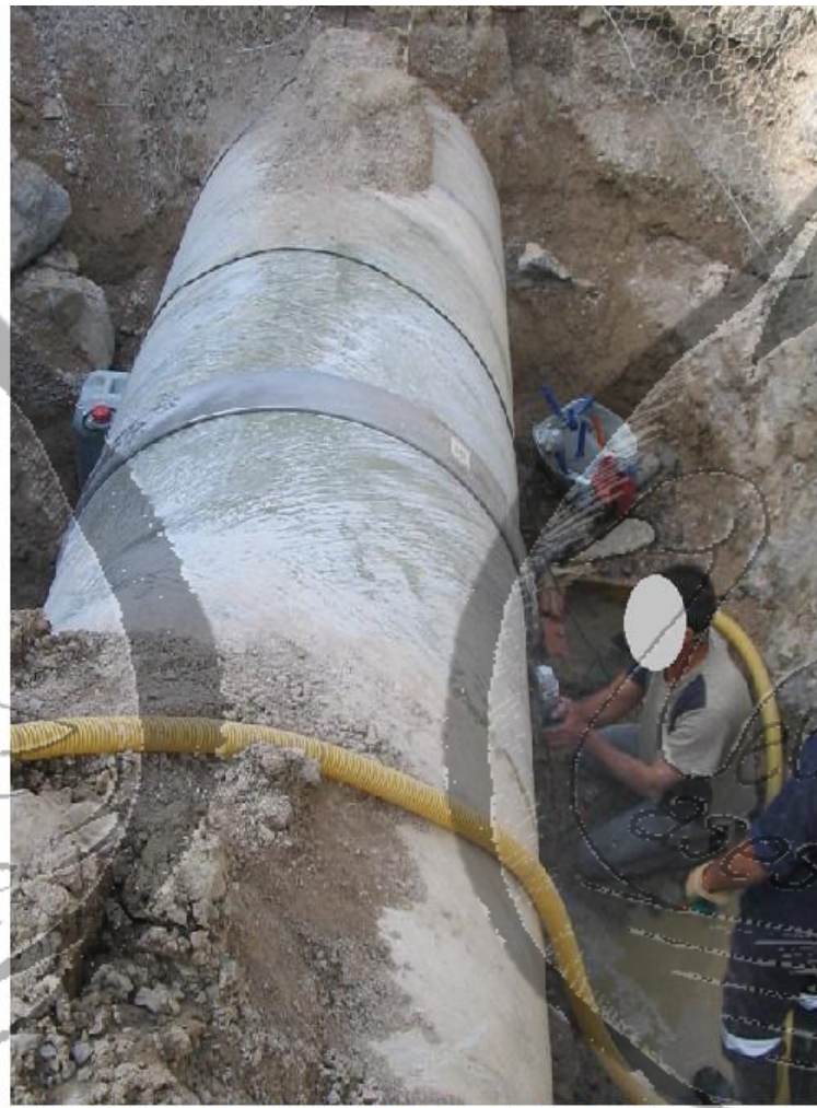
LIJADO COMPLETO PERIMETRAL DEL TUBO, EN ANCHURA SUFICIENTE, PARA, TRAS LIMPIEZA, ADAPTAR LAS TELAS DE FIELTRO DE FIBRA DE VIDRIO IMPREGNADAS EN RESINA DE POLIÉSTER
