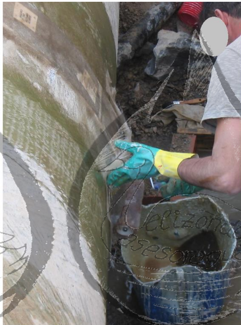
COLOCACIÓN DE LAS CAPAS DE FIELTRO DE FIBRA DE VIDRIO SUPERPUESTAS E IMPREGNADAS CON RESINA DE POLIÉSTER
