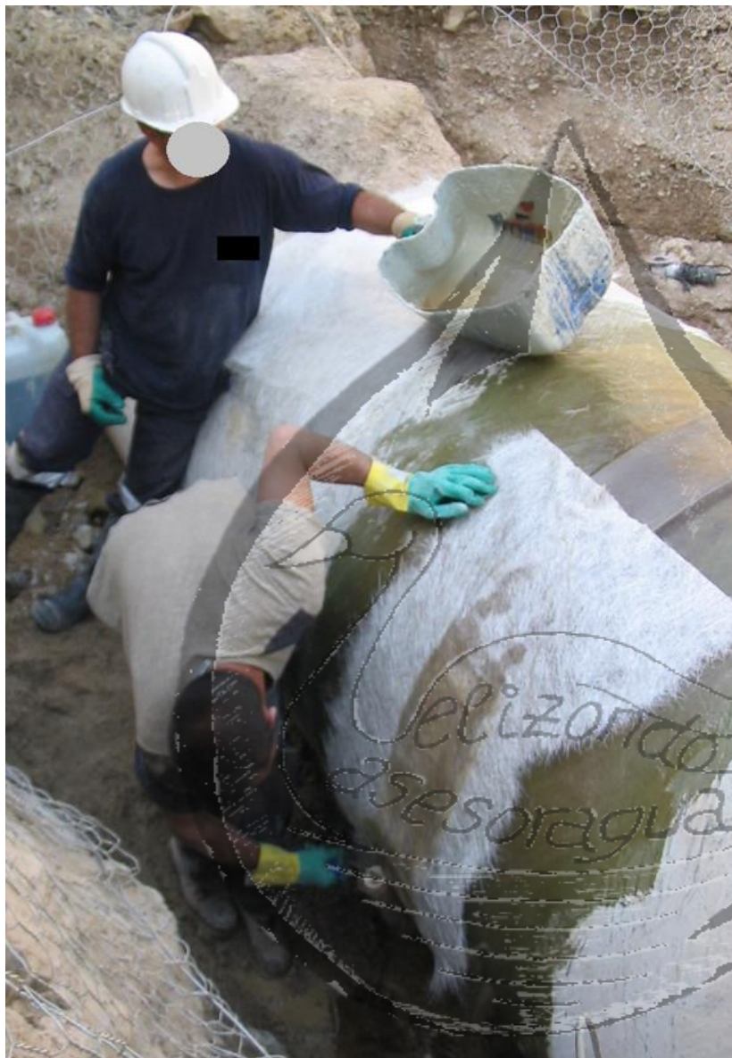
COLOCACIÓN DE LAS CAPAS DE FIELTRO DE FIBRA DE VIDRIO SUPERPUESTAS E IMPREGNADAS CON RESINA DE POLIÉSTER
