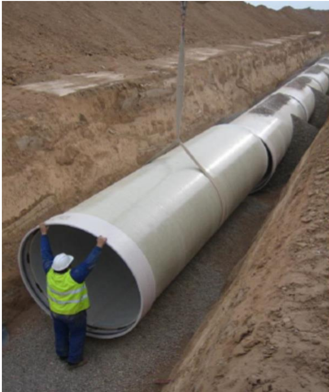
FACILIDAD DE MANIPULACIÓN EN OBRA, DE TUBOS POLIÉSTER REFORZADO CON FIBRA DE VIDRIO (PRFV), INCLUSO CON TUBOS DE GRAN LONGITUD
