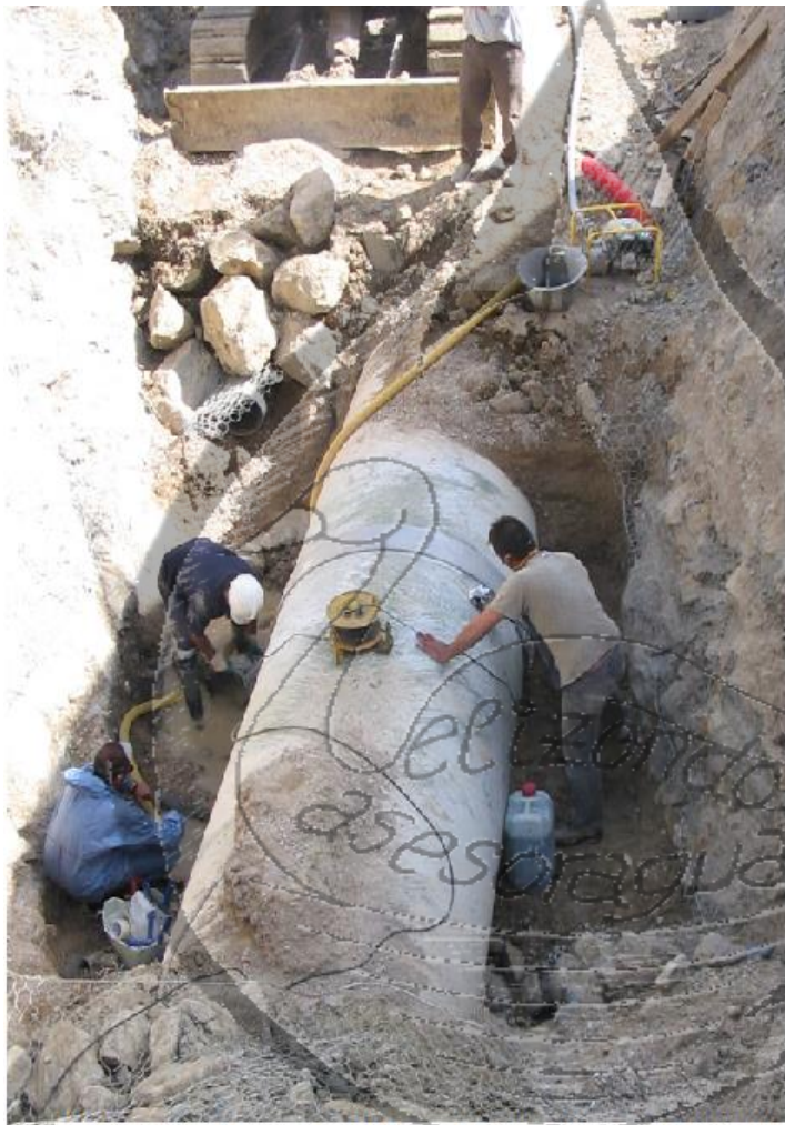
LIJADO COMPLETO PERIMETRAL DEL TUBO, EN ANCHURA SUFICIENTE, PARA, TRAS LIMPIEZA, ADAPTAR LAS TELAS DE FIELTRO DE FIBRA DE VIDRIO IMPREGNADAS EN RESINA DE POLIÉSTER
