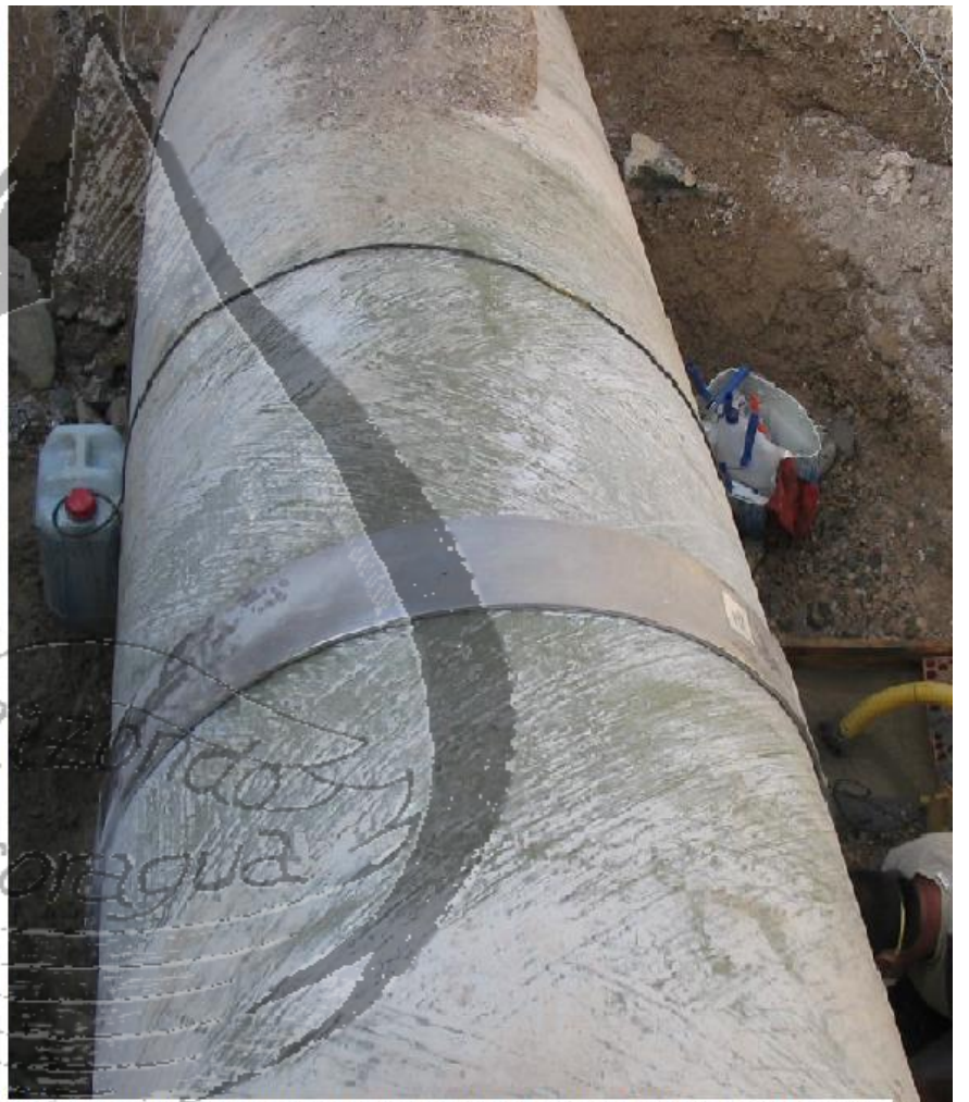
LIJADO COMPLETO PERIMETRAL DEL TUBO, EN ANCHURA SUFICIENTE, PARA, TRAS LIMPIEZA, ADAPTAR LAS TELAS DE FIELTRO DE FIBRA DE VIDRIO IMPREGNADAS EN RESINA DE POLIÉSTER
