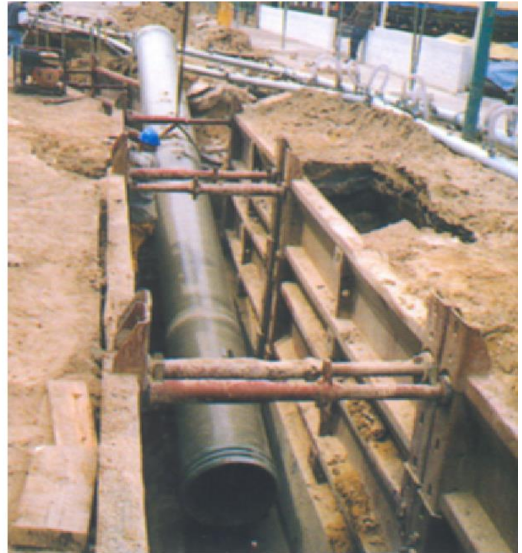
FACILIDAD DE MANIPULACIÓN EN OBRA, DE TUBOS POLIÉSTER REFORZADO CON FIBRA DE VIDRIO (PRFV), INCLUSO CON TUBOS DE GRAN LONGITUD
