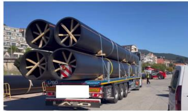
TRANSPORTE DE LOS TUBOS Y MANIPULACIÓN EN OBRA (CON LAS PROTECCIONES PARA EVITAR LA OVALIZACIÓN Y PROBLEMAS EN LA CONSECUCCIÓN DE LAS SOLDADURAS A TOPE)
