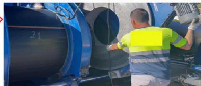
REFRENTADO DE CARAS REALIZADO E INTRODUCCIÓN DE LA PLACA CALEFACTORA PARA FUNDIR EL POLIETILENO DE AMBAS
