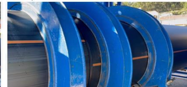
EXTRACCIÓN PLACA CALEFACTORA Y UNIÓN EXTREMOS TUBOS A PRESIÓN, PARA CONFORMAR LA SOLDADURA ENTRE AMBOS
