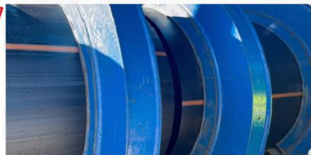
EXTRACCIÓN PLACA CALEFACTORA Y UNIÓN EXTREMOS TUBOS A PRESIÓN, PARA CONFORMAR LA SOLDADURA ENTRE AMBOS
