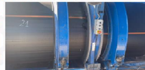
REFRENTADO DE CARAS REALIZADO E INTRODUCCIÓN DE LA PLACA CALEFACTORA PARA FUNDIR EL POLIETILENO DE AMBAS
