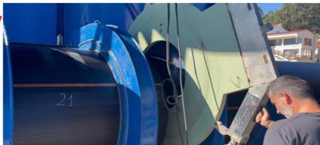
EXTRACCIÓN PLACA CALEFACTORA Y UNIÓN EXTREMOS TUBOS A PRESIÓN, PARA CONFORMAR LA SOLDADURA ENTRE AMBOS
