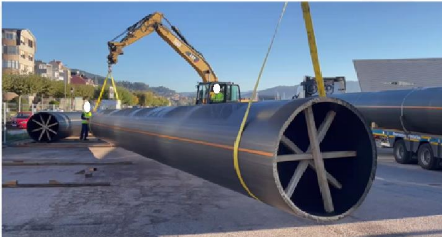
TRANSPORTE DE LOS TUBOS Y MANIPULACIÓN EN OBRA (CON LAS PROTECCIONES PARA EVITAR LA OVALIZACIÓN Y PROBLEMAS EN LA CONSECUCCIÓN DE LAS SOLDADURAS A TOPE)
