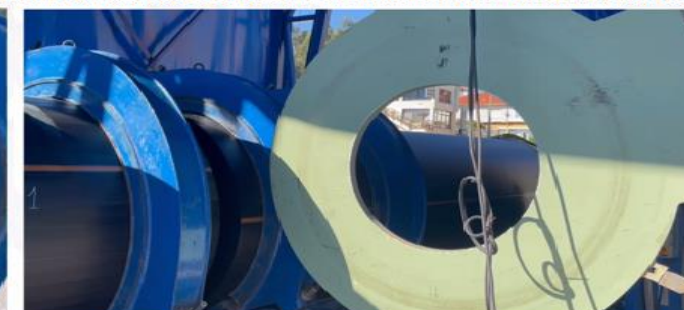
EXTRACCIÓN PLACA CALEFACTORA Y UNIÓN EXTREMOS TUBOS A PRESIÓN, PARA CONFORMAR LA SOLDADURA ENTRE AMBOS
