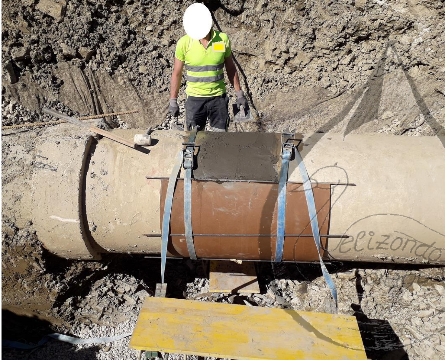
CAPA EXTERNA DEL TUBO RECONSTRUIDA, DEJADA PARA SU CURADO, Y EJEMPLO DE CÓMO QUEDA FINALMENTE EL TUBO TRAS LA INTERVENCIÓN COMPLETA
