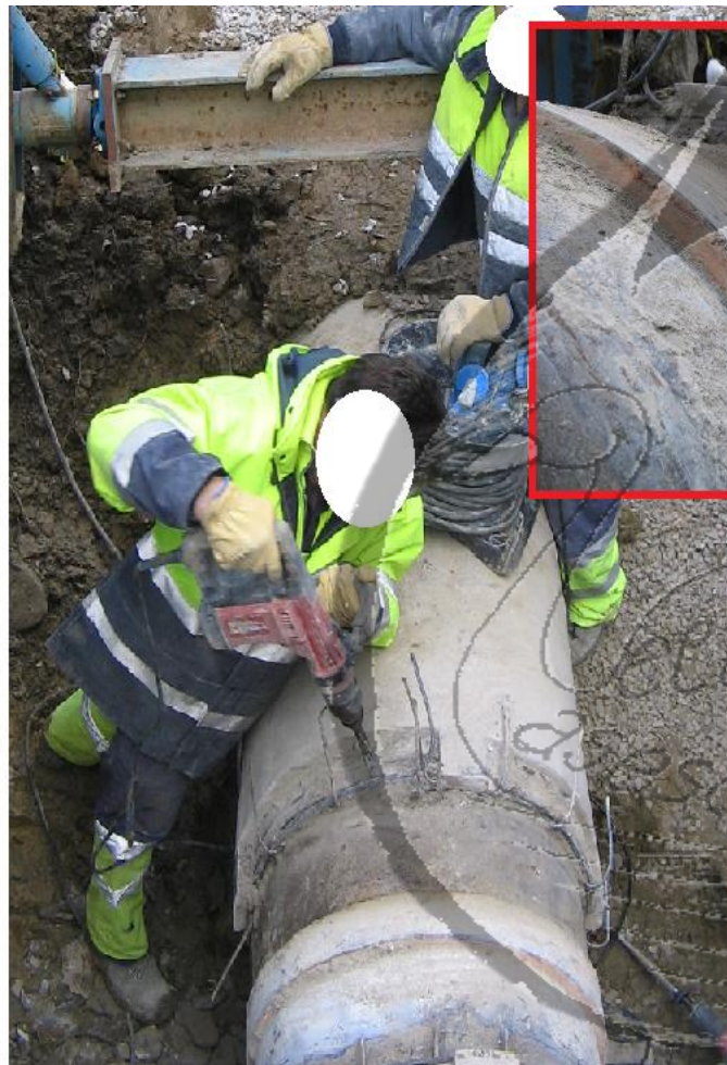
FUGA EN LA UNIÓN DE TUBOS DN600HACch (HORMIGÓN ARMADO CAMISA DE CHAPA) RETIRADA DE LA ENVOLTURA PARA DEJAR LIBRE LA UNIÓN POR CHAPA SOLDADA, Y LAS DISTANCIAS PARA LAS VIROLAS A SOLDAR A LAS CAMISAS DE CHAPA LATERALES.
