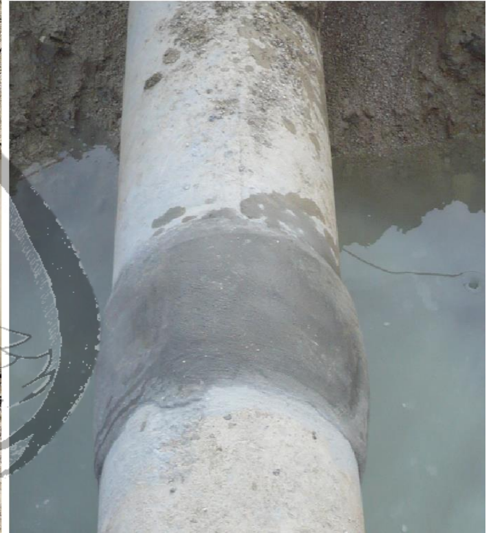
CAPA EXTERNA DEL TUBO RECONSTRUIDA, DEJADA PARA SU CURADO, Y EJEMPLO DE CÓMO QUEDA FINALMENTE EL TUBO TRAS LA INTERVENCIÓN COMPLETA
