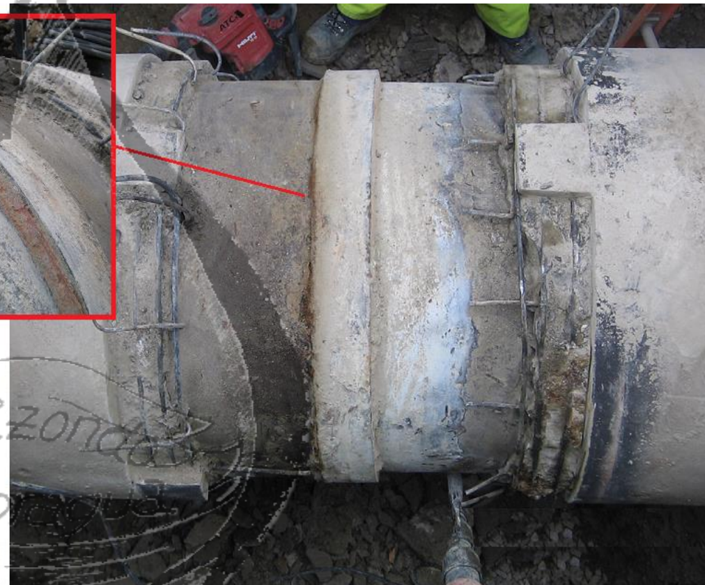
FUGA EN LA UNIÓN DE TUBOS DN600HACch (HORMIGÓN ARMADO CAMISA DE CHAPA) RETIRADA DE LA ENVOLTURA PARA DEJAR LIBRE LA UNIÓN POR CHAPA SOLDADA, Y LAS DISTANCIAS PARA LAS VIROLAS A SOLDAR A LAS CAMISAS DE CHAPA LATERALES.
