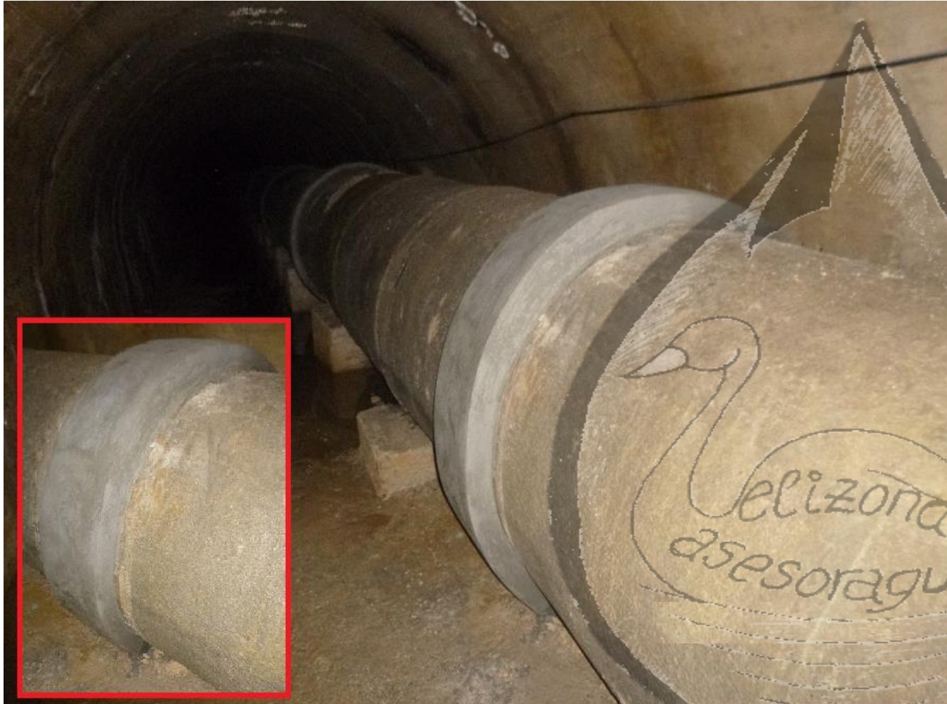
JUNTAS TUBOS 1000HACCh EN TÚNEL. RECONSTRUCCIÓN ENVOLVENTES TRAS LIMPIEZAS ENVOLVENTES AFECTADAS, PROYECCIÓN ELIMINACIÓN HERRUMBRE, PASIVACIÓN E IMPRIMACIÓN ANTICORROSIÓN Y RECONSTRUCCIÓN ENVOLVENTE
