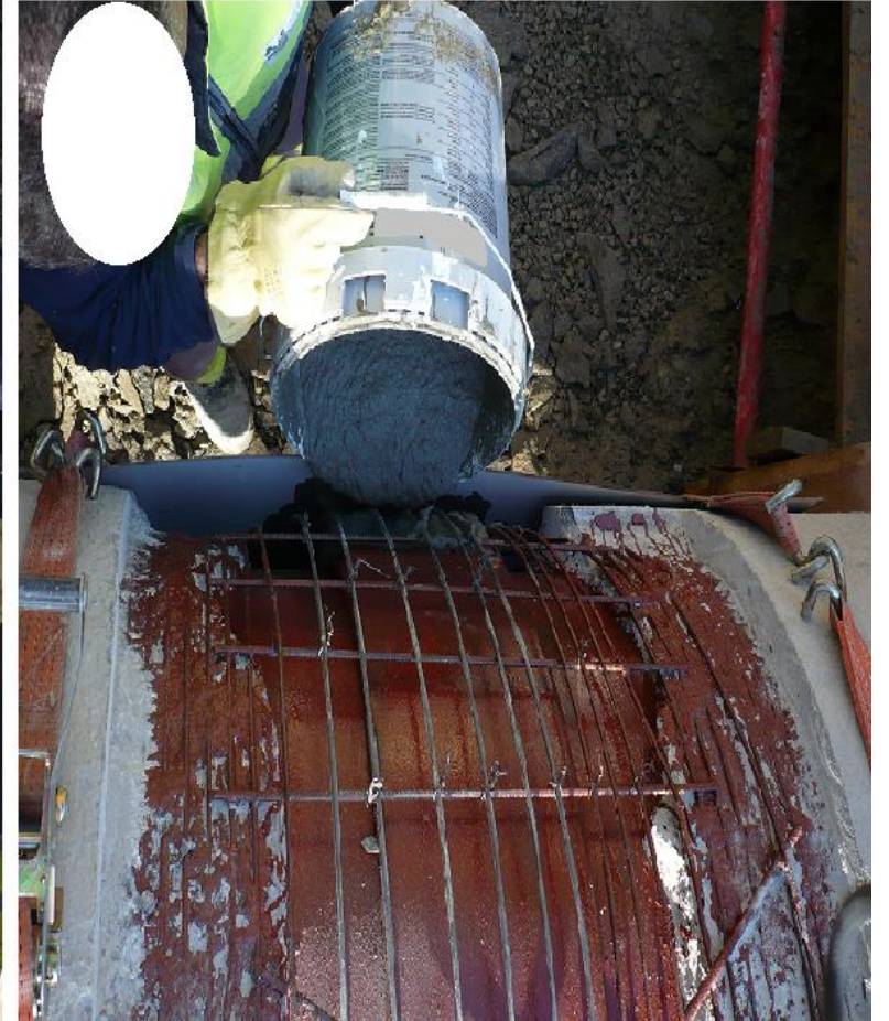
RECONSTRUCCIÓN CAPA EXTERNA DEL TUBO CON CEMENTO PROTECTOR Y CON LA TEXTURA QUE PERMITA LA HOMOGENEIZACIÓN PERIMETRAL
