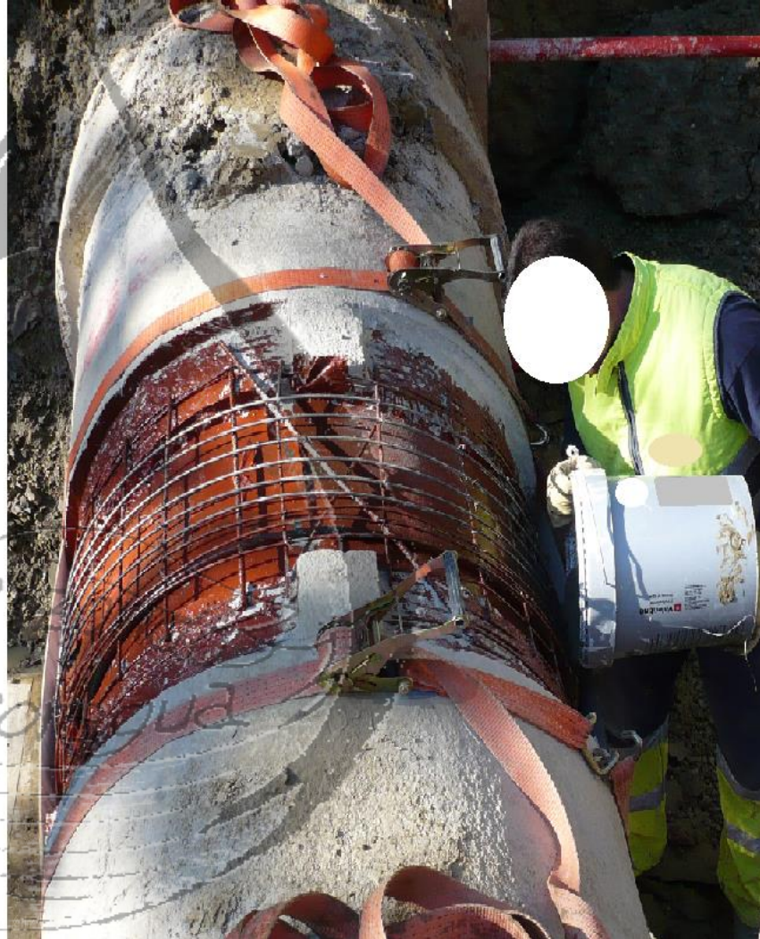
RECONSTRUCCIÓN CAPA EXTERNA DEL TUBO CON CEMENTO PROTECTOR Y CON LA TEXTURA QUE PERMITA LA HOMOGENEIZACIÓN PERIMETRAL
