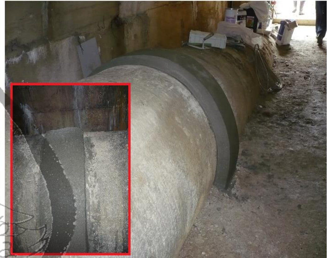
JUNTAS TUBOS 1000HACCh EN TÚNEL. RECONSTRUCCIÓN ENVOLVENTES TRAS LIMPIEZAS ENVOLVENTES AFECTADAS, PROYECCIÓN ELIMINACIÓN HERRUMBRE, PASIVACIÓN E IMPRIMACIÓN ANTICORROSIÓN Y RECONSTRUCCIÓN ENVOLVENTE
