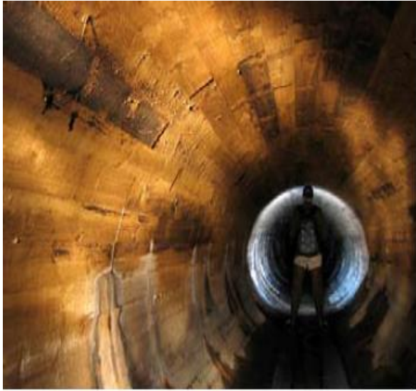
Tuberías de madera para saneamiento en Victoria (Columbia Británica, Canadá), todavía en funcionamiento
