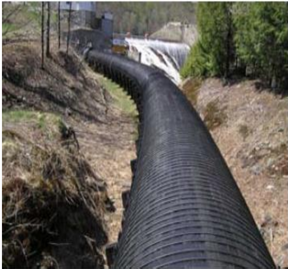
Tuberías de madera para saneamiento en Victoria (Columbia Británica, Canadá), todavía en funcionamiento
