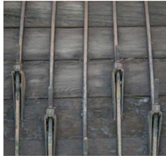
Detalle de la tubería de madera de cedro rojo que se utilizó desde 1930 hasta 1991 para llevar el agua del río Cedar a Seattle, Washington, EE.UU.. Obsérvense las bandas de metal que daba rigidez a las duelas. Se encuentra ahora en exposición en el museo Maple Valley Historical Society cerca del centro de Valle de Maple. Fotos Joe Mabel (mayo 2009)
