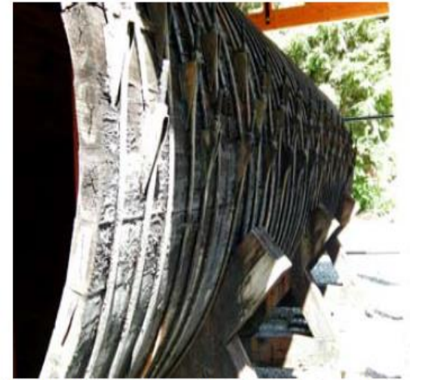
Detalle de la tubería de madera de cedro rojo que se utilizó desde 1930 hasta 1991 para llevar el agua del río Cedar a Seattle, Washington, EE.UU.. Obsérvense las bandas de metal que daba rigidez a las duelas. Se encuentra ahora en exposición en el museo Maple Valley Historical Society cerca del centro de Valle de Maple. Fotos Joe Mabel (mayo 2009)
