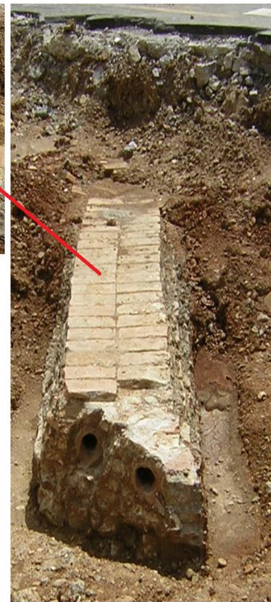
TUBERÍAS CERÁMICAS AL DESCUBIERTO CON LA REURBANIZACIÓN DE LA ZONA DE CARLOS III (PROBABLES TUBERÍAS DE LA TRAÍDA DE AGUAS DESDE SUBIZA)
