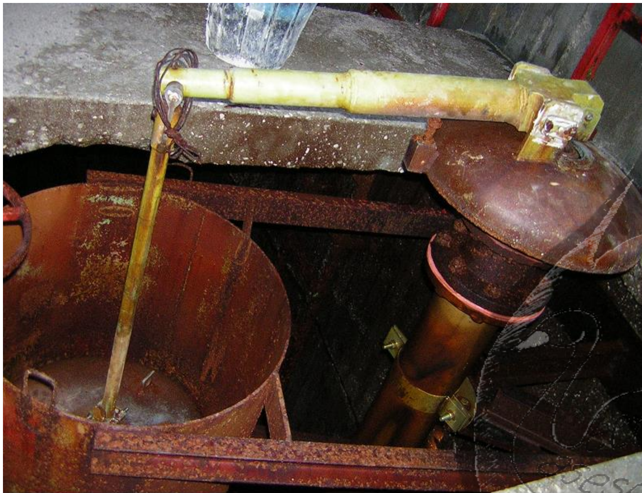
REGULACIÓN DE NIVEL DE DEPÓSITO MEDIANTE OBTURADOR BAJO CAPOTA (DESMONTADO EN DEPÓSITO REHABILITADO Y SUSTITUIDO POR VÁLVULA AUTOMÁTICA DE TIPO HIDRÁULICO COMANDADA POR PILOTO ALTIMÉTRICO)
