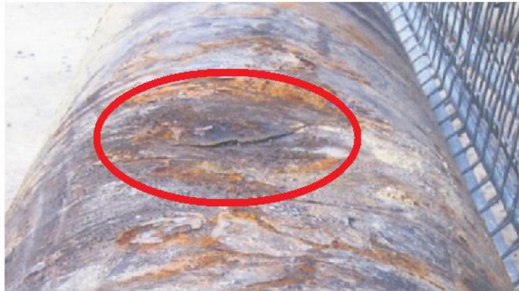
AFECCIÓN A TUBERÍA DN400FN POR PESO DE INFRAESTRUCTURA DE GAS APOYADA DIRECTAMENTE SOBRE ELLA, EJECUTADA SIN CONOCIMIENTO EMPRESA DE SERVICIO, Y OBRA A LA QUE CONLLEVA
