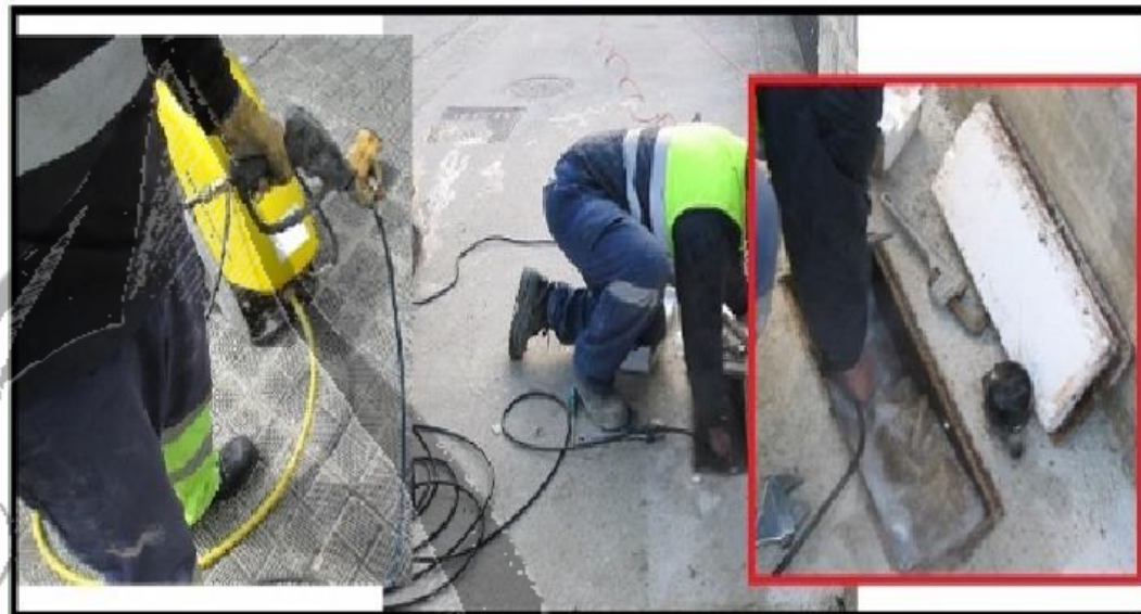
Introducción del agua caliente a presión en la acometida para su descongelamiento y poder restablecer el servicio
