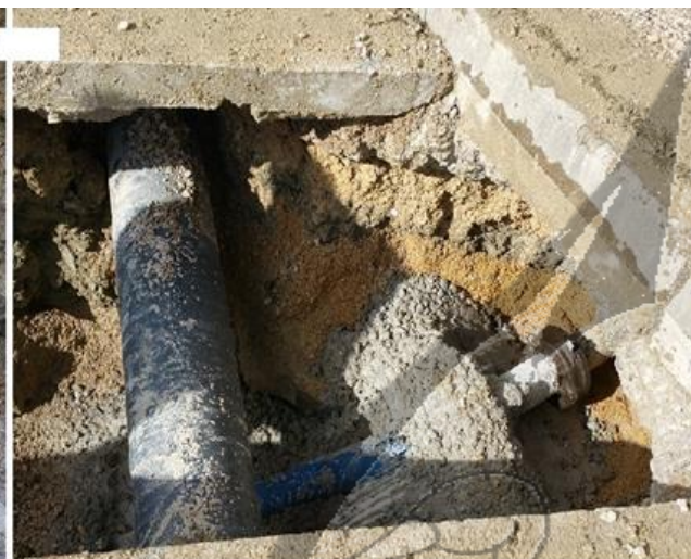
ANCLAJES AFECTANDO PIEZAS EJEMPLO
