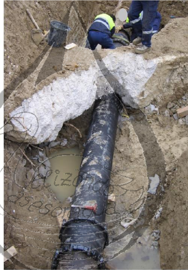
AFECCIÓN A TUBERÍA DN400FN POR PESO DE INFRAESTRUCTURA DE GAS APOYADA DIRECTAMENTE SOBRE ELLA, EJECUTADA SIN CONOCIMIENTO EMPRESA DE SERVICIO, Y OBRA A LA QUE CONLLEVA
