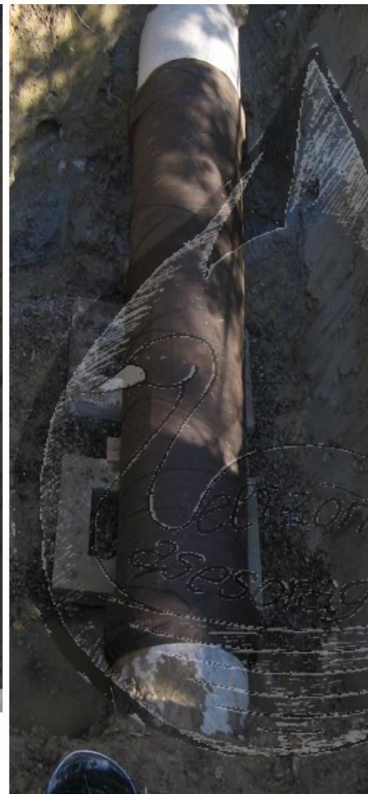
PROTECCIÓN CON CINTA DE TIPO GRASO, ATADA CON ALAMBRE PLASTIFICADO PARA SUJECCIÓN
