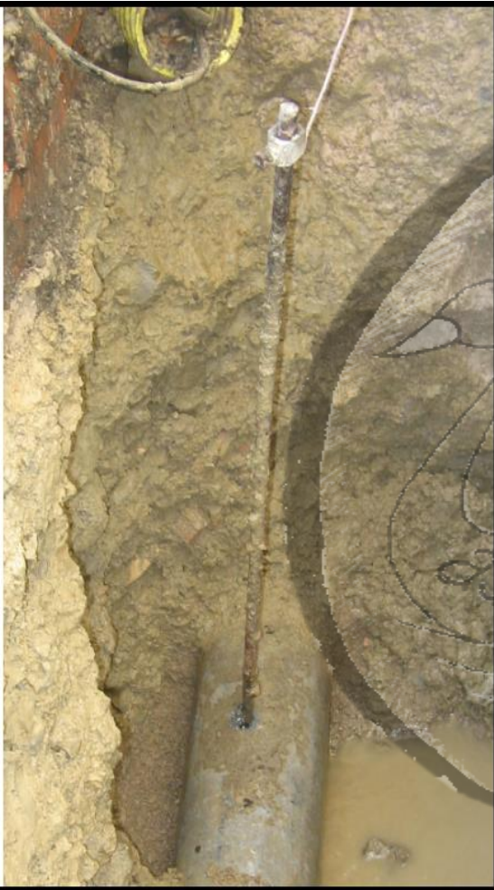
AFECCIÓN A TUBERÍA DE FC POR HINCADO TOMA TIERRA
