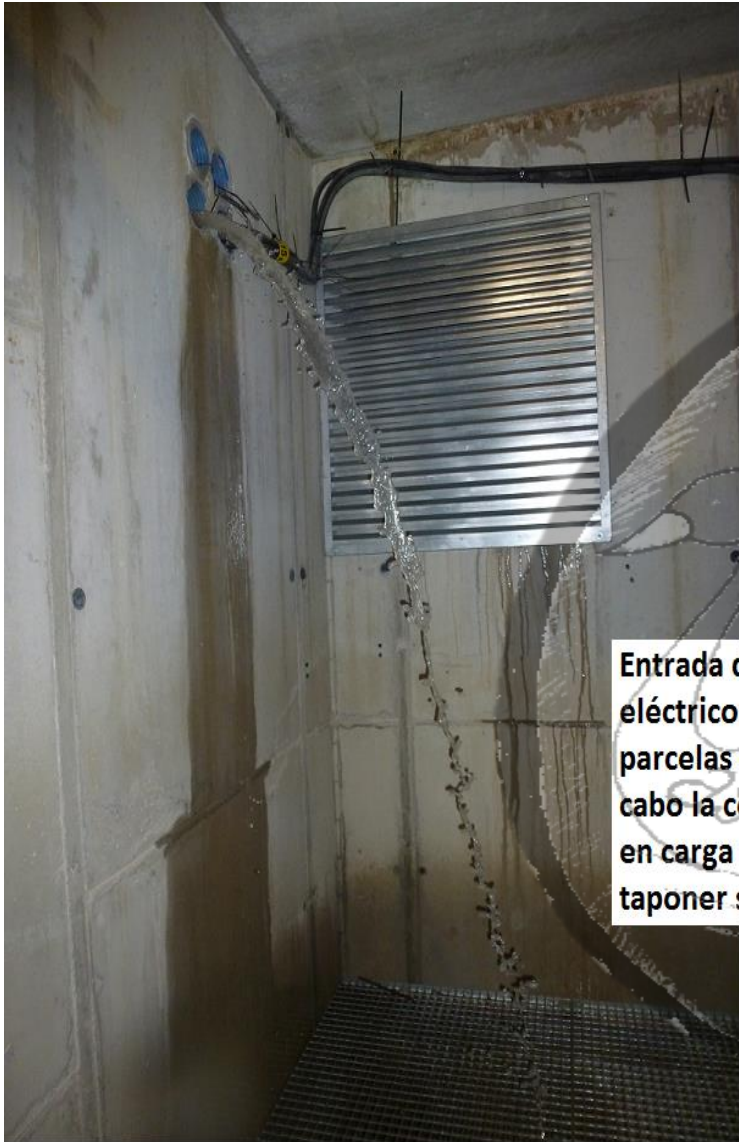
INUNDACIÓN GALERÍA POR ENTRADA AGUA EXTERIOR
