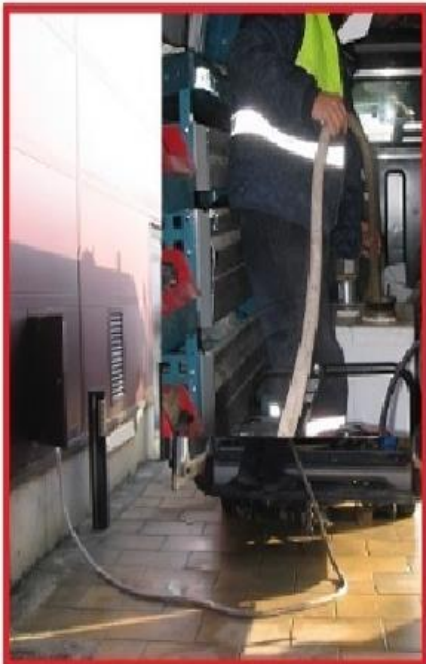
carga de agua caliente de caldera (60-70º) a tanque isoterma móvil
