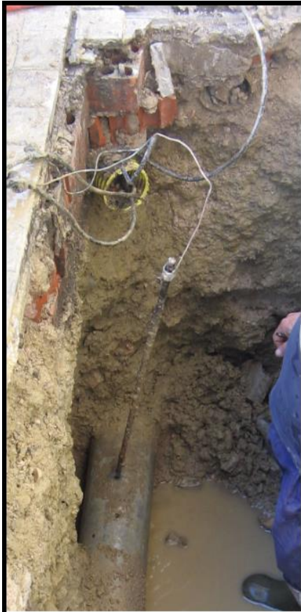
AFECCIÓN A TUBERÍA DE FC POR HINCADO TOMA TIERRA
