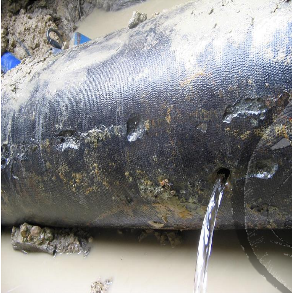
APERTURA DE ZANJA POR LA DETECCIÓN DE FUGA EN TUBERÍA FN Y OBERVACIÓN DE CORROSIÓN GENERALIZADA QUE LLEVA A TENER QUE SUSTITUIR UN TRAMO Y GENERAR AVISO PARA RENOVACIÓN
