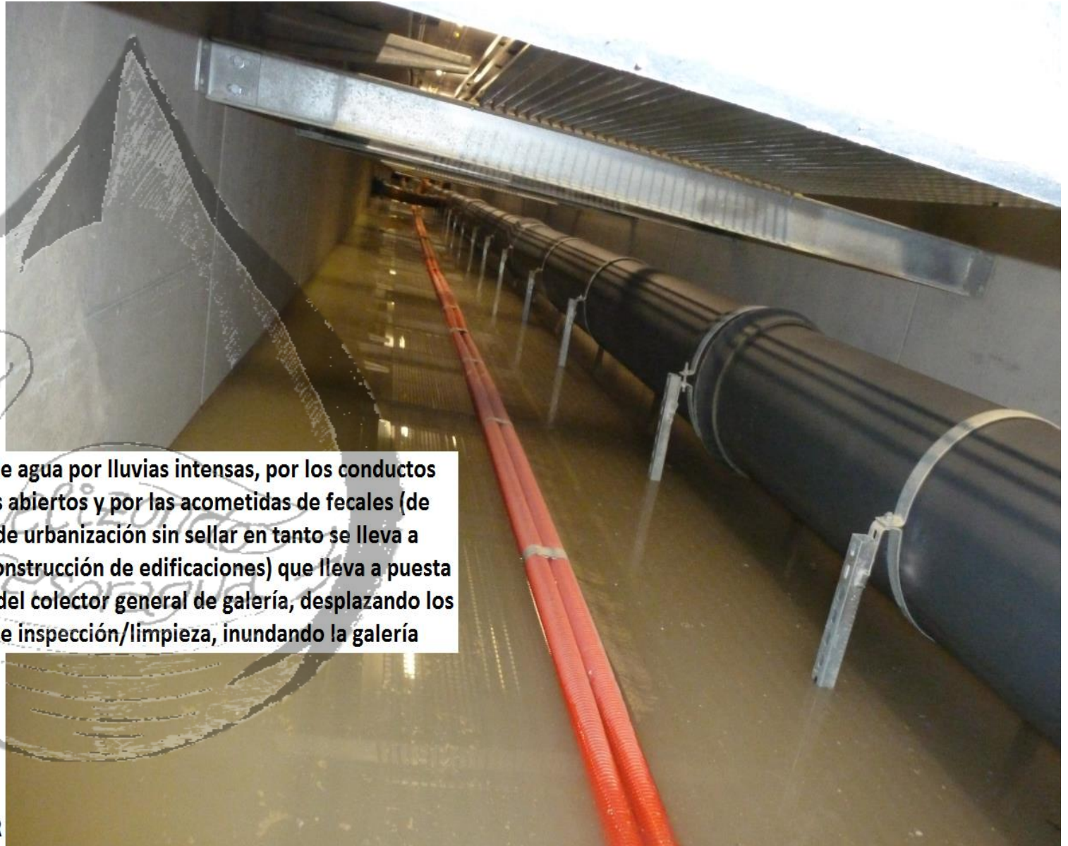
INUNDACIÓN GALERÍA POR ENTRADA AGUA EXTERIOR
