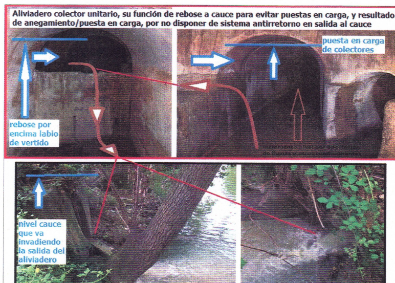
FIGURA 16. Aliviaderos para protección de anegamientos.
