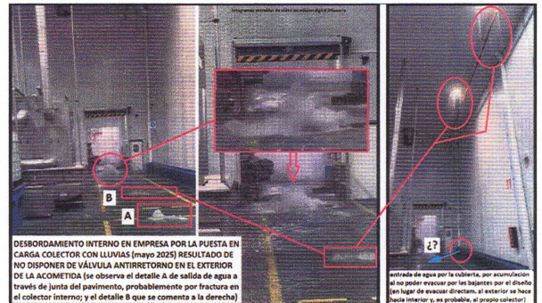
FIGURA 3. Bajantes de pluviales a interior en edificación.
