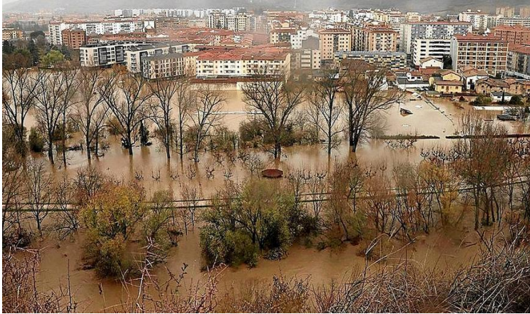
Vista general de Burlada durante las inundaciones de 2021. OSKAR MONTERO
