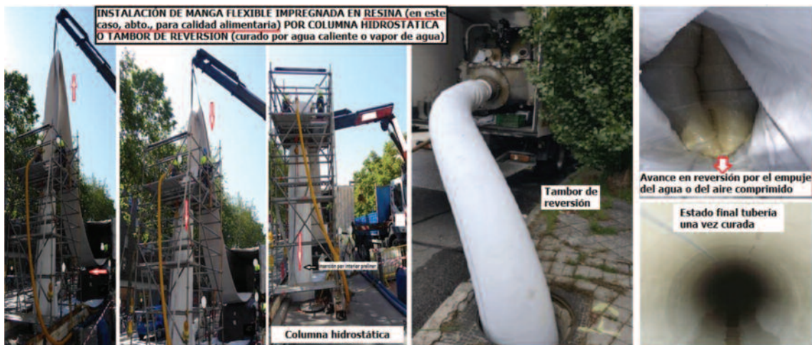
No se planteó ejecutar con sistema de inserción por tracción y curado con rayos ultravioleta, por presencia de los codos que podían condicionar el paso del tren de lámparas
