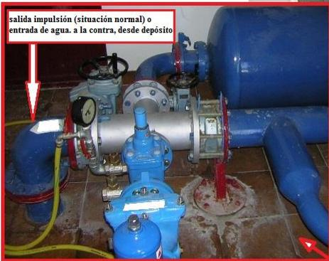
**EJEMPLO PRÁCTICO (REAL) DE SUMINISTRO ALTERNATIVO A LA ZONA PREVIA DE UN BOMBEO, CON LAS MISMAS CONDICIONES DE PRESIÓN, MEDIANTE LA DISPOSICIÓN DE UN BYPASS CON REDUCTORA DE PRESIÓN EN EL PROPIO BOMBEO, PARA SUMINISTRO A LA CONTRA POR LA PROPIA IMPULSIÓN, MIENTRAS SE RESUELE LA ANOMALÍA (AVERÍA Y/O ACTUACIÓN DE MANTENIMIENTO)**
