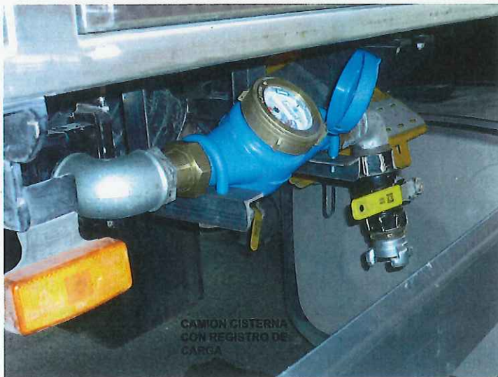
Figura 4. Carga de agua controlada (imagen de la izquierda) e incontrolada (imagen de la derecha).
