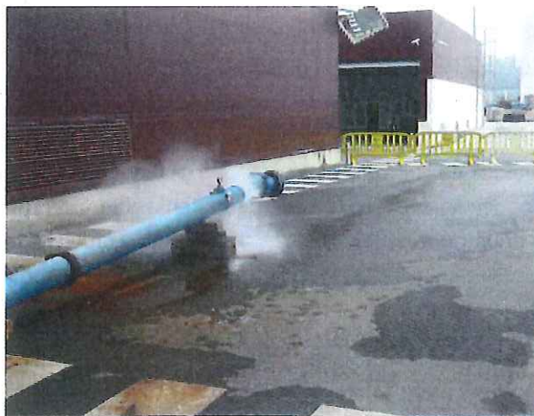
FIGURA 5. Disipación de calor en la descompresión.
